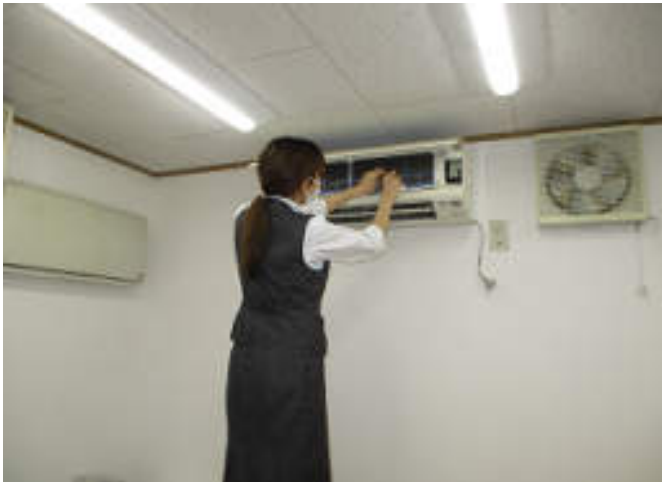
👉 エアコン清掃の実施
